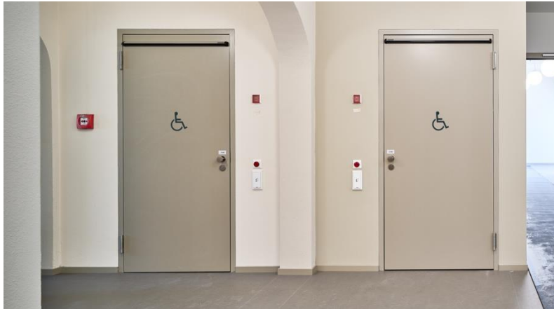
Bild 3: Die einzelnen Komponenten der barrierefrei geprüften Schörghuber-Türen lassen sich untereinander kombinieren und mit Funktionen wie Brand-, Rauch- oder Schallschutz ausstatten.
