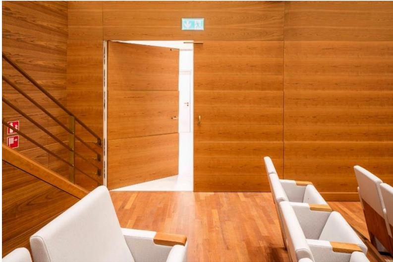
**Bild 1:** Konferenzräume haben oft höhere Schallschutzanforderungen, als es der Standard vorsieht. Wenn gleichzeitig eine schlanke Ausführung gewünscht ist, bietet die Schallschutztür von Schörghuber mit  $R_{w,P} = 47$  dB eine stimmige Lösung – auch im Großformat und zweiflügelig.
