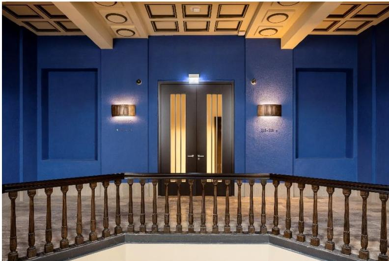
**Bild 7:** Die dem Original nachgebildete Deckengestaltung und eine Galerieebene über der Hotellobby. Eine doppelflügelige Schörghuber T30 Brandschutztür verbindet die Galerie mit dem Zimmerflügel im rückwärtigen Hotelbereich.
