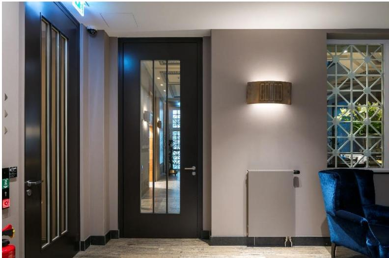
**Bild 8:** Im Kontrast zu den beigefarbenen Wandflächen gestaltete man die mit Lichtausschnitten ausgestatteten Schörghuber T30 Brandschutztüren der Hotelflure in Graubraun. Die 50 Millimeter starken Hotelzimmereingangstüren sind ebenfalls Rauchschutztüren und erfüllen teilweise Schallschutzwerte von  $R_{w,P} = 42$  dB.
