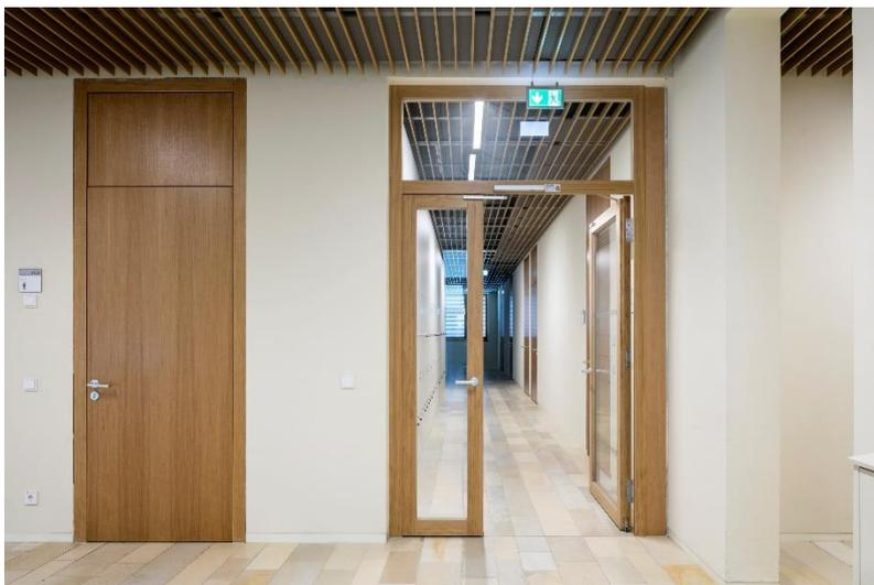
**Bild 4:** Die in den Fluren und Treppenhäusern eingesetzten Schörghuber Türelemente müssen den Anforderungen an T30 oder T90 Brandschutz, Rauchschutz und Barrierefreiheit entsprechen.
