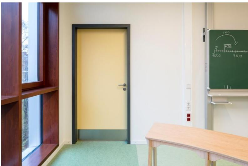
**Bild 8:** Edelstahl-Sockelbleche als Trittschutz schützen die Oberfläche und verleihen der Tür Wertigkeit.
