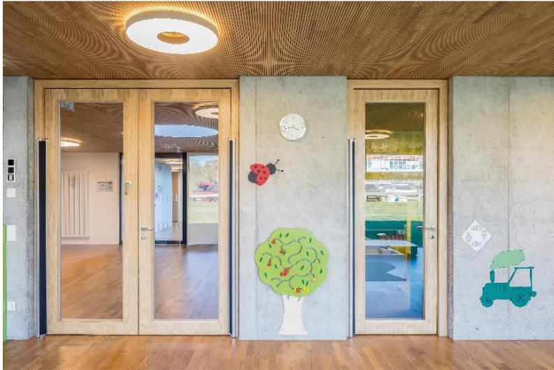
**Bild 4:** Damit die Kinder sich nicht verletzen, sind die Schallschutztüren von Schörghuber mit Fingerschutzrollos und abgerundeten Kanten ausgeführt.
