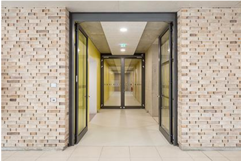
Bild 14: Die raumhoch ausgeführten Stahl-Rohrrahmenelemente von Hörmann sind aufgrund ihrer Materialität besonders robust und langlebig. Sie kamen in den Fluren der Schule zum Einsatz.
