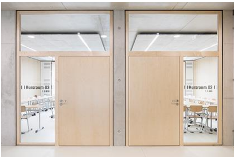
Bild 11: Schörghuber Türen mit vollflächig verglasten Seitenteilen und Oberlichtern führen in die Klassenräume und sorgen für Transparenz und Lichteinfall. Aluminium-Schattennutprofile schaffen elegante Übergänge zwischen Tür und Sichtbetonwand.
