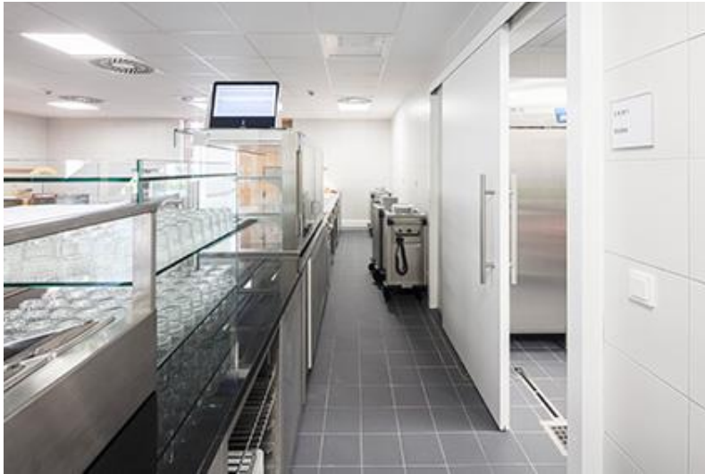
Bild 8: Eine Vollspan-Schiebetür von Schörghuber führt in die Küche und verhindert, dass sich Gerüche zur Essensausgabe und in die Mensa ausbreiten. Die Schiebetür liegt platzsparend an der Wand und gibt im geöffneten Zustand die volle Durchgangsbreite frei.
