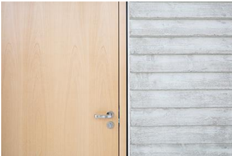
Bild 15: Materialkombination: Schörghuber Holztür mit Rotbuchen-Furnier und Beton-Stülp-schalung.
