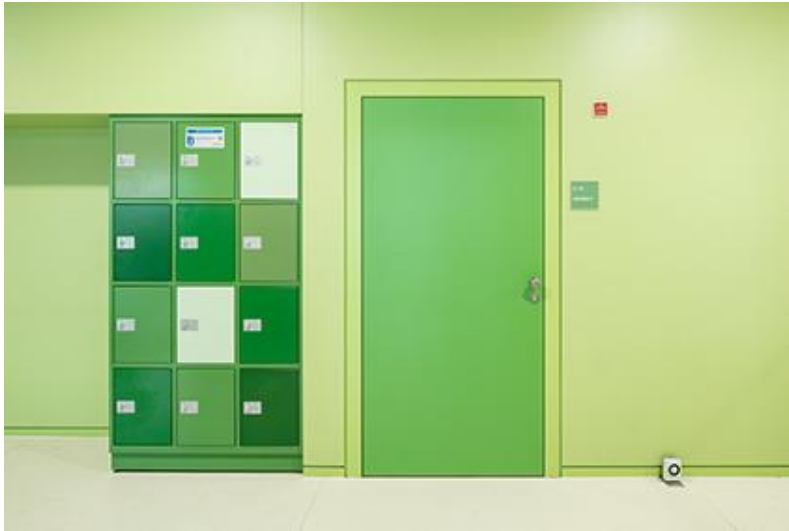
Bild 12: Wand, Tür und Schließfächer folgen einem Farbkonzept – hier im grünen Cluster. Die Schörghuber Feuchtraumtür hält Feuchtigkeit und einer hohen Benutzerfrequenz stand.
