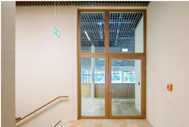
**Bild 4:** Mit Oberlicht und Seitenteil teilen die Schörghuber Massivholz-Rahmentüren auch große Durchgänge in Objekten räumlich ab und schaffen so unter anderem Brandabschnitte zwischen verschiedenen Bereichen eines Gebäudes.
