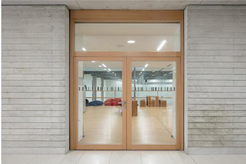
**Bild 2:** Massivholz-Rahmentüren von Schörghuber sorgen für Transparenz und Lichtdurchlässigkeit in Gebäuden und erfüllen darüber hinaus hohe Anforderungen an Brand-, Rauch- und Schallschutz – wie beispielsweise dieses zwei-flügelige Türelement mit Oberlicht in der neuen Gesamtschule in Lippstadt.
