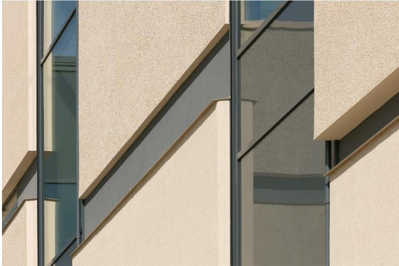
**Bild 2:** Die Fassade des Kurhauses in Bad Alexandersbad unterteilt sich in aneinandergereihte Steine, die durch senkrechte Glasfugen getrennt werden. Die Form der Fassade soll an die für die Region typische Gesteinsformation der Wollsockverwitterung erinnern. **Foto: Constantin Meyer, Köln / Brückner & Brückner Architekten GmbH**
