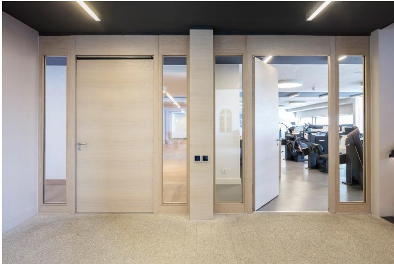
Bild 12: Sport wird nicht nur im Wasser getrieben, sondern auch im Fitnessraum des Kurhauses. Den Zugang ermöglichen Schörghuber Türen mit wandbündigen Massivholz-Stockzargen und verglasten Seitenteilen.
