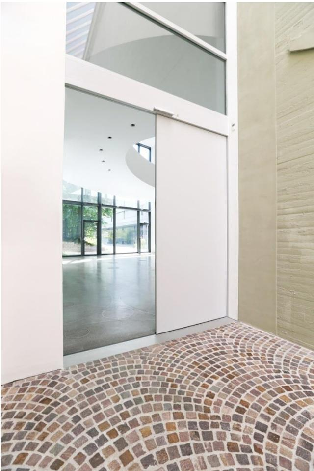
**Bild 9:** Blick in den Calder-Saal vom Ende der Museumstraße. Im Brandfall trennt die Schörghuber Brandschutztür die beiden Bereiche voneinander ab und verbindet diese im normalen Tagesbetrieb.
