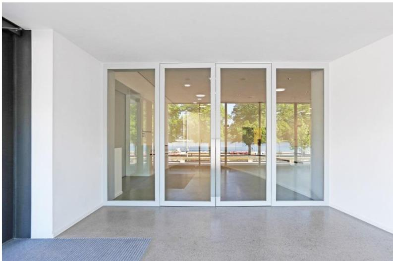
**Bild 5:** Zugang über das Foyer des Neubaus. In der großflächig verglasten Schörghuber Massivholz-Rahmentür spiegelt sich der vis a vie liegende Maschsee. Für noch mehr Transparenz wurde die zweiflügelige Tür beidseitig mit Festverglasungen kombiniert.
