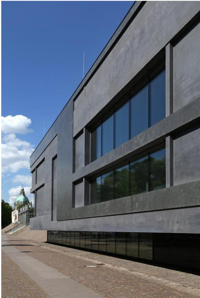
**Bild 7:** Die Betonfassade des Museums wurde vor Ort gegossen und durch mehrere Schleifgänge bearbeitet. Im Hintergrund des Gebäudes erscheint das Neue Rathaus Hannovers, das sich in Laufnähe befindet.
