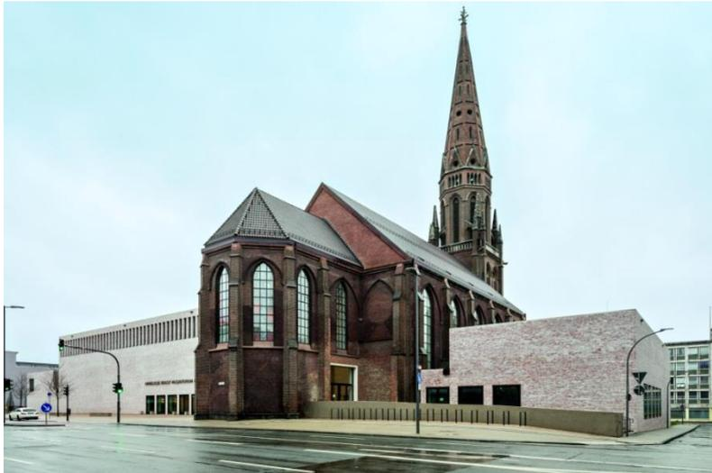
**Bild 2:** Nicht nur farblich ragt die Sankt-Marien-Kirche hervor. Links und rechts von ihr befinden sich die Anbauten, deren Klinker eine optische Verbindung zum Bestandsbau schafft.
