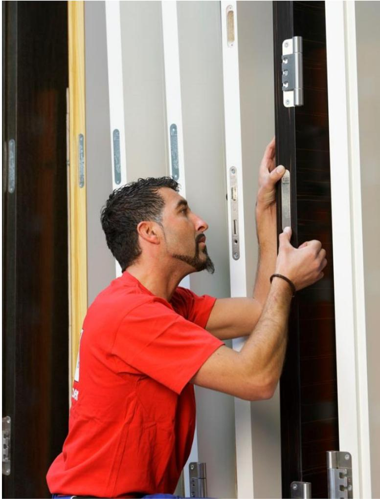
**Bild 5:** Um Verarbeitern den Einbau der Funktionstüren zu erleichtern und somit für Zeit- und Kostenersparnis auf der Baustelle zu sorgen, werden alle Zargen und Türblätter bei Schörghuber bereits im Werk für die spätere Montage vorbereitet.
