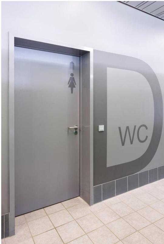
**Bild 2:** In Nassraumbereichen müssen Türen im täglichen Gebrauch direkter Nässe und dem Einfluss von Reinigungsmitteln unbeschadet standhalten. Die T30-Nassraumtür trotz diesen Einflüssen mit einer serienmäßig angegossenen PU-Schutzkante und der besonders robusten HPL-Oberfläche. Zudem schützt die Spezialtür im Brandfall bis zu 30 Minuten vor Übergreifen des Feuers.
