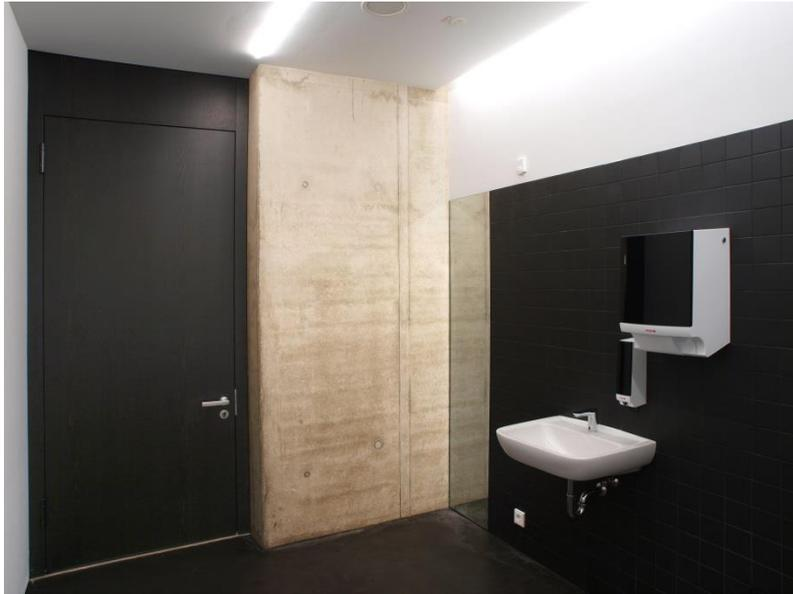
**Bild 1:** Um Holzzargen in Bereichen mit regelmäßiger Feuchtigkeitseinwirkung vor Aufquellen des Materials zu schützen, stattet Schörghuber diese optional mit einem bauseitig unsichtbaren Feuchteschutz aus und verlängert so wesentlich die Langlebigkeit der Zargen.
