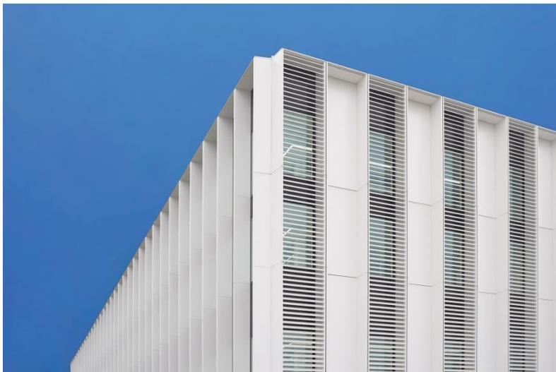
**Bild 2:** Der metallverkleidete Kubus verhindert Störsignale auf das Flughafenradar und sorgt gleichzeitig dafür, dass Sonneneinstrahlung und Wärmeeintrag so gering wie möglich ausfallen.
