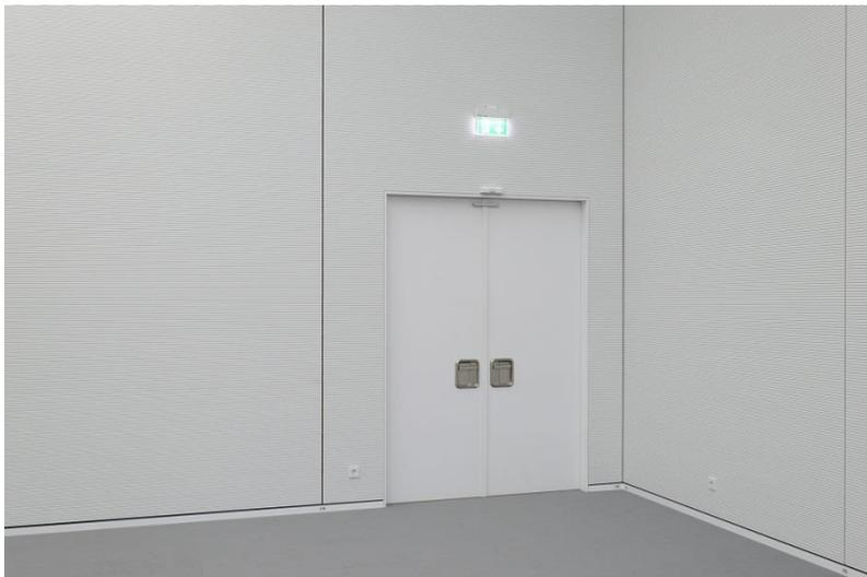
**Bild 4:** Die zweiflügelige Eingangstür zum Kontrollraum entspricht komplexen Anforderungen an Schall- und Brandschutz. Die HPL-Beschichtung in weiß integriert die Schörghuber Tür harmonisch in die Optik.
