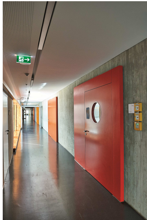
Bild 5/6: Die Schörghuber Schallschutztüren zu den Klassenzimmern (teilweise mit Glasausschnitt) heben sich nicht nur farblich vom nackten Beton ab. Sie sind zudem in einer leicht in den Raum ragenden, aufgesetzten Wandscheibe platziert.
