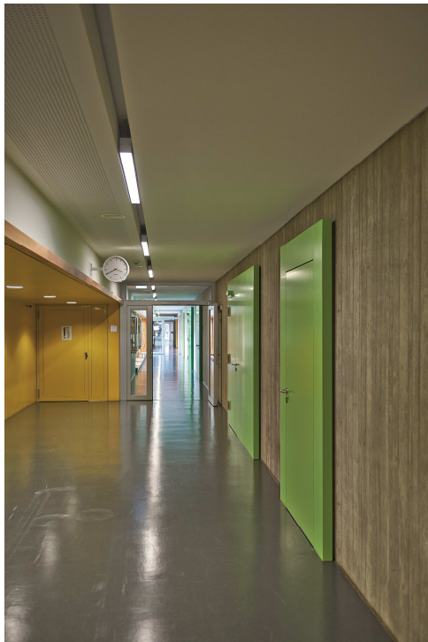
Bild 5/6: Die Schörghuber Schallschutztüren zu den Klassenzimmern (teilweise mit Glasausschnitt) heben sich nicht nur farblich vom nackten Beton ab. Sie sind zudem in einer leicht in den Raum ragenden, aufgesetzten Wandscheibe platziert.
