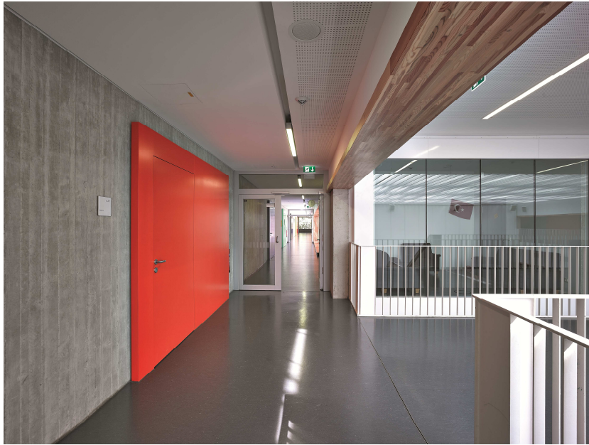
Bild 4: Schörghuber T30 Massivholz-Rahmentüren mit Glasoberlicht trennen die einzelnen Brandabschnitte des Flures voneinander ab.
