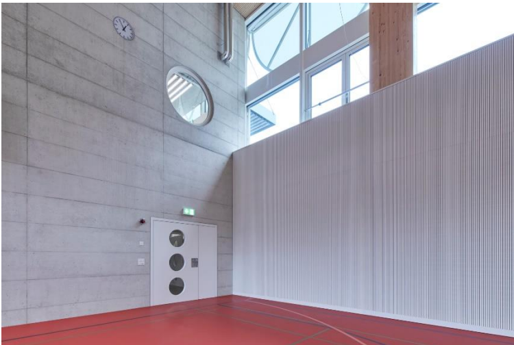
Bild 13: Die Sporthalle wird über eine zweiflügelige Tür mit „Bullaugen“ erschlossen.
