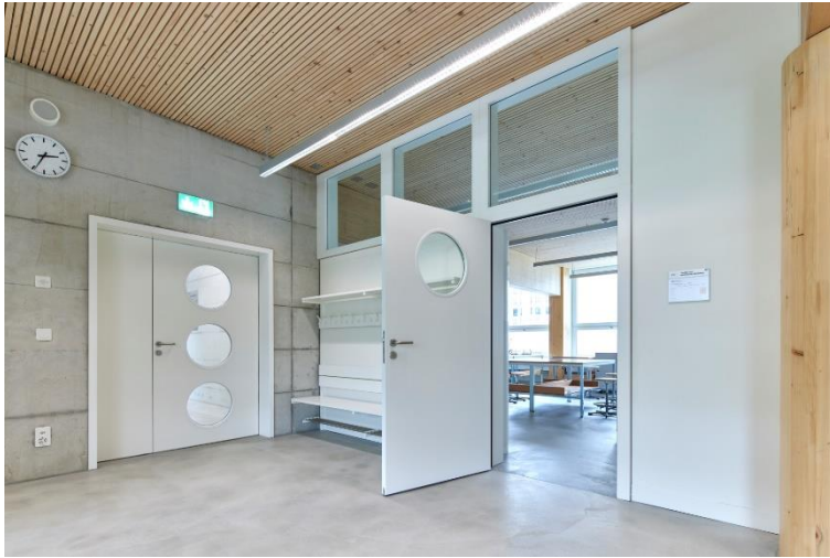
Bild 10: Oberlichter ergänzen die Schörghuber Türen zu den Klassenzimmern.
