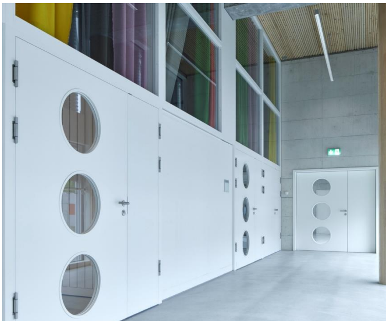
Bild 11: Die Gesamthöhe dieser Flurtrennwände beträgt in manchen Bereichen stattliche 5 m.
