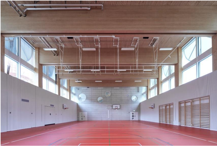
Bild 12: Ebenso wie die Klassenräume und Flure entstand auch die Sporthalle innerhalb kürzester Zeit aus vorgefertigten Holzmodulen in Systembauweise.
