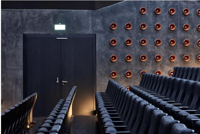
**Bild 4:** Die Schörghuber Schallschutztür der Ausführung „Access“ benötigt lediglich eine Dichtungsebene in der Türzarge. Sie ist mit weiteren Funktionen erhältlich und kann neben der 1-flügeligen Variante nun auch 2-flügelig ausgeführt werden.
