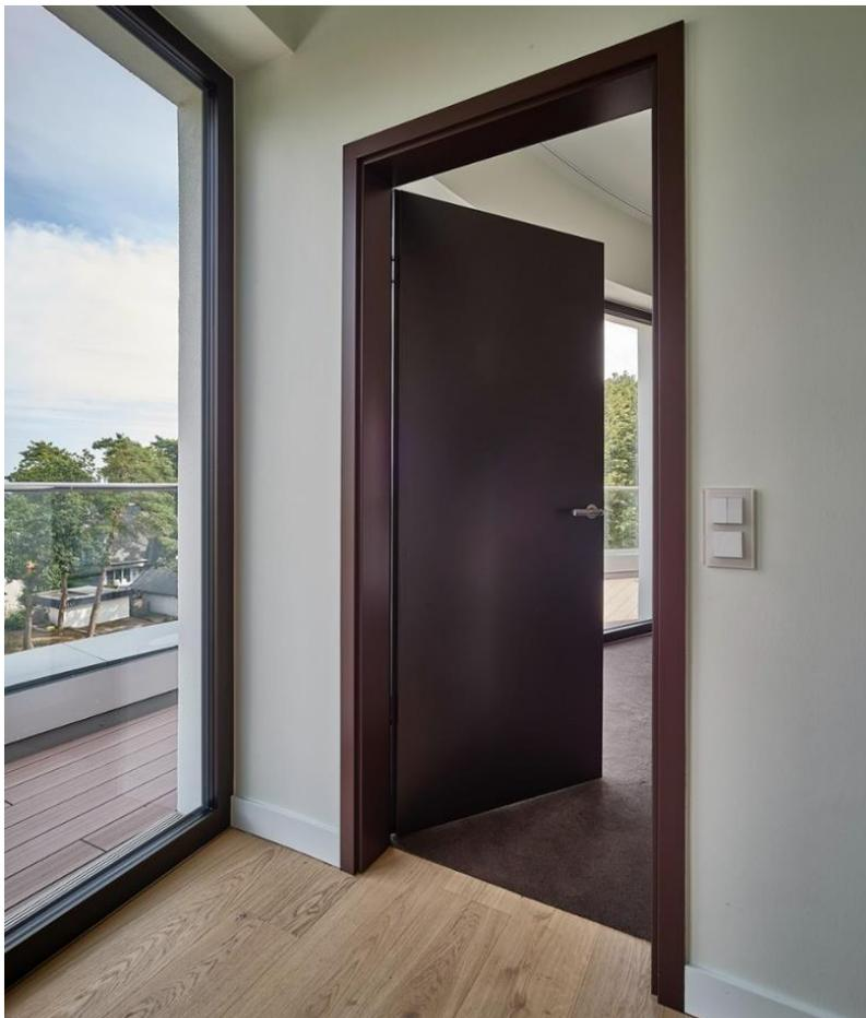
**Bild 4:** Für den Einbau der Schörghuber VarioFix Zarge eignen sich Massivwände ebenso wie auch Leichtbau- oder Holzständerwände.
