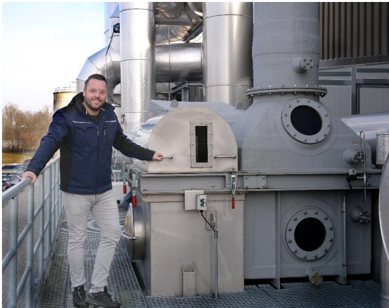
Bild 2: Schörghuber Mitarbeiter Sebastian Kostic betreut die neue Rauchgasreinigungsanlage am Firmenstandort in Ampfing. Auf dem Bild steht er vor dem Tiefbettfaserfilter, einer wichtigen Komponente der Rauchgasfilterung. Er erklärt: „Im Tiefbettfaserfilter durchströmen die Rauchgase eine Filtermatte. Hier werden feinste Feststoffe und Aerosole einbehalten.“
