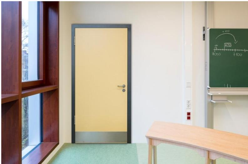
**Bild 2:** Dank ihrer platzsparenden Ausführung reduziert sich das lichte Durchgangsmaß in der Höhe um nur 10 mm und in der Breite um nur 20 mm.
