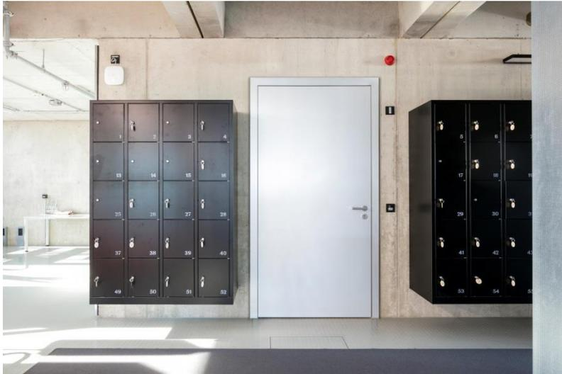
**Bild 1:** Die Stahlsanierungseckzarge von Schörghuber wird auf der Bestandszarge befestigt. Funktionen wie T30 Brandschutz, Rauchschutz sowie Schallschutz bis  $R_w, P = 42$  dB lassen sich im Sanierungsfall mit dieser Zarge einfach und schnell erfüllen.
